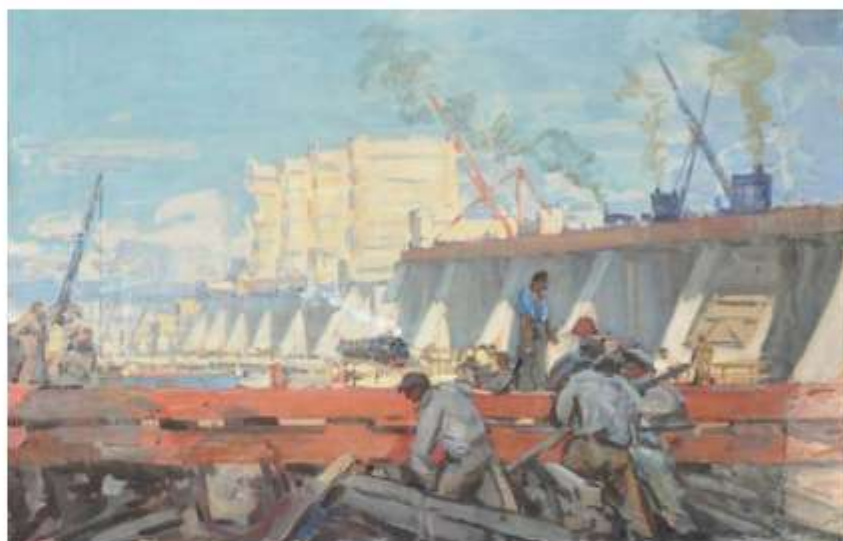
Олексій Шовкуненко. Будівництво греблі ДніпроГЕСу
