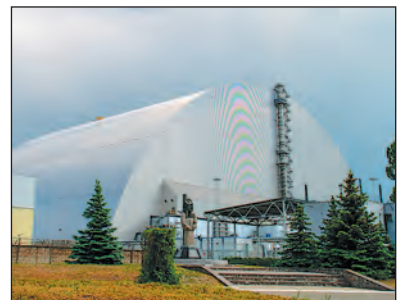
Арка безпеки над зруйнованим у результаті аварії 4-м енергоблоком Чорнобильської АЕС
