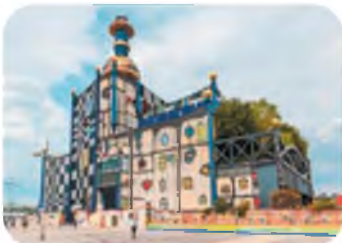
Завод з переробки сміття. Австрія
